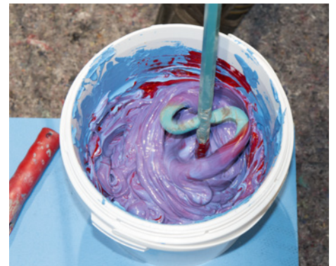
Mischen der Flüssigfolie bis homogene Farbe entsteht
